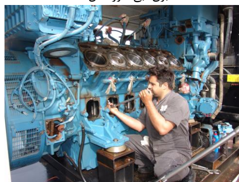
عملیات نصب دیزل ژنراتورهای شرکت بهره‌برداری، تولید و انتقال آب جنوب شرق
